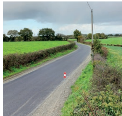
Réfection Route du Boisniard.
